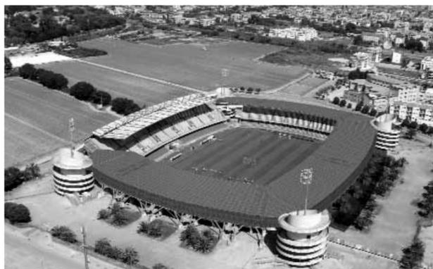
e da profili anch'essi in acciaio di varie dimensioni. Il manto di copertura sarà costituito da pannelli in lamiera preverniciata, sia nella parte superiore che in quella inferiore, dotata di nervature con particolari
